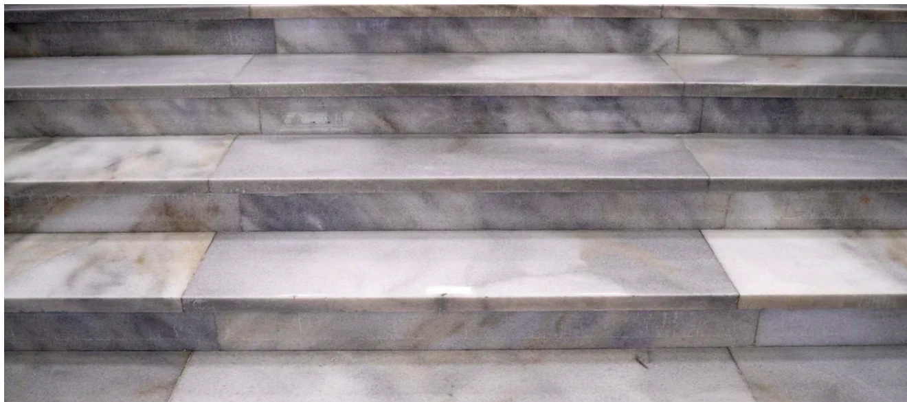
Шлифовка, полировка лестничных маршей. Общеобразовательная школа
