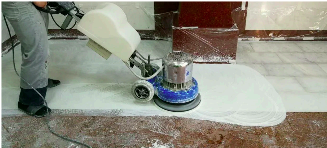
Шлифовка, полировка лестничных маршей. Общеобразовательная школа
